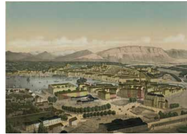
François Métral, Genève, démolition des fortifications de Rive, après 1849, BGE-CIG • Genève, vue de la ville depuis la rive droite, vers 1862, BGE-CIG
